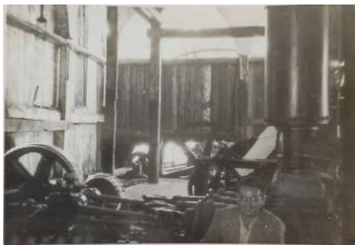
Ο Κρίτων Ηλιάδης στο μηχανοστάσιο του Τσάρκι 1947
